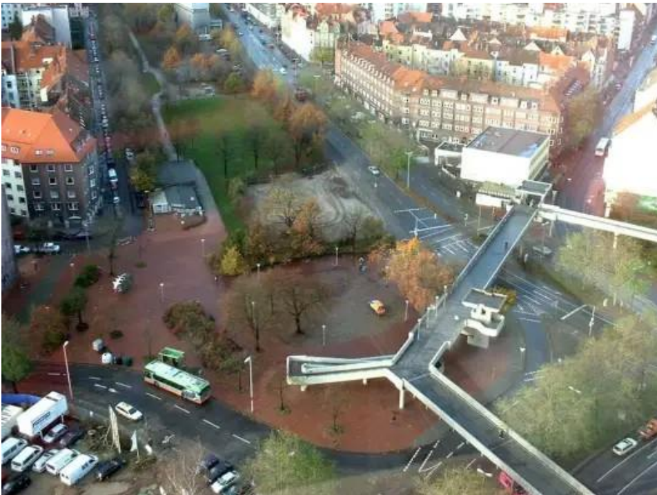
Abb. 8: Historische Aufnahme vom Küchengarten in Hannover
